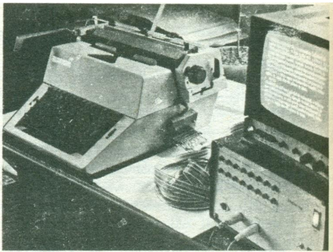
A Simonyi-féle számítógép konfigurációja, billentyűzetnek használt írógéppel. Fotó: A Mikroszámítógép Magazin 1984/2-es számából
